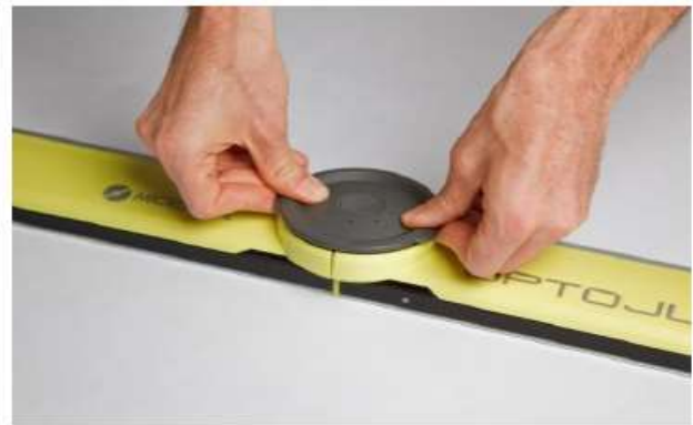
Fig.16.17-キャップを地面と平行にしたまま軽く押し組む
